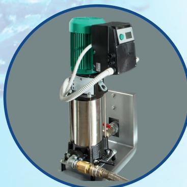
I sistemi di pressurizzazione a basamento, abbinabili alle preautoclavi per fornire la prevalenza/portata richieste, sono realizzati con pompe inverter ad alta efficienza e della migliore qualità e sono progetti speciali predisposti con il cliente.
