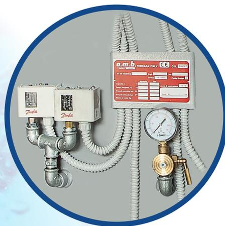
Dettaglio della targa dati OMB, dei pressostati di servizio e controllo e del manometro con relativo rubinetto di intercettazione.
