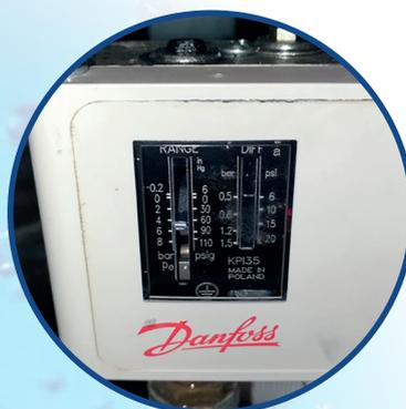
Particolare pressostato di minima, a taratura regolabile.
